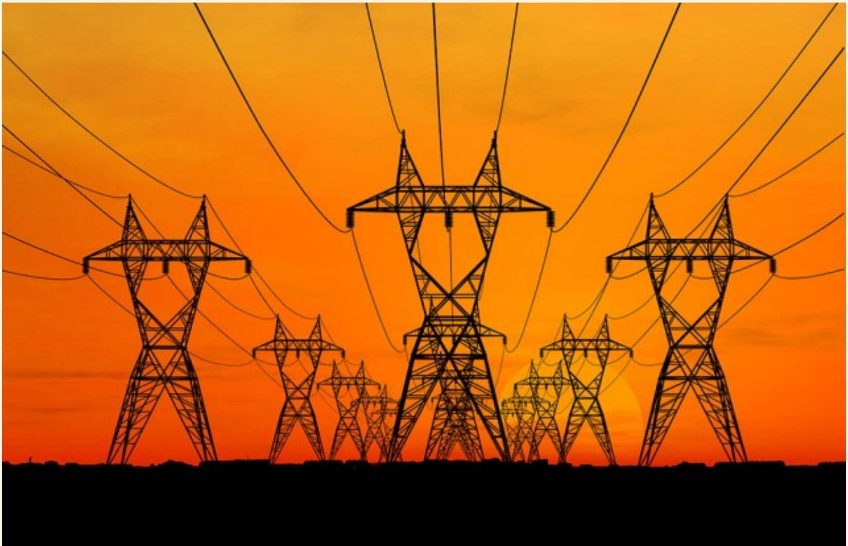
Líneas de alta tensión
