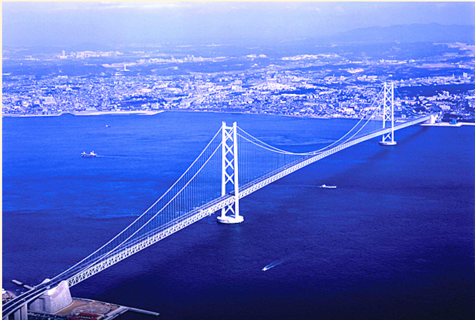
Puente Akashi Kaikyo (Japón)
