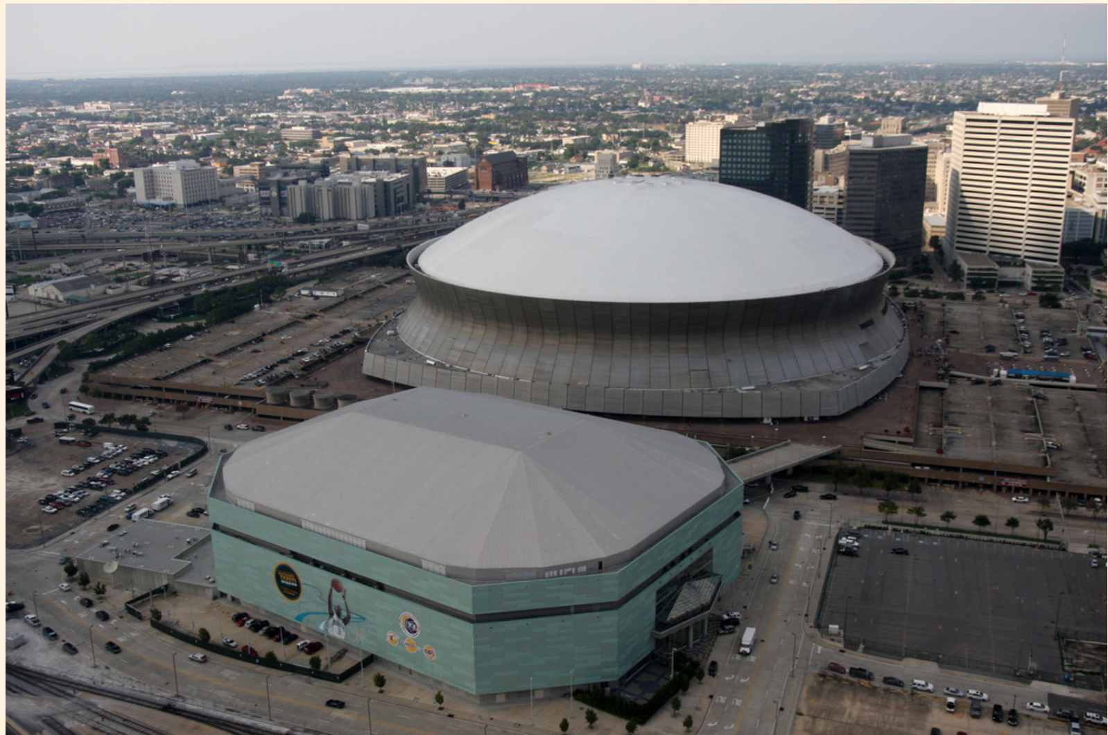
Superdome de Nueva Orleans (USA) Imagen por cortesía de Jacinta Quesada/FEMA
