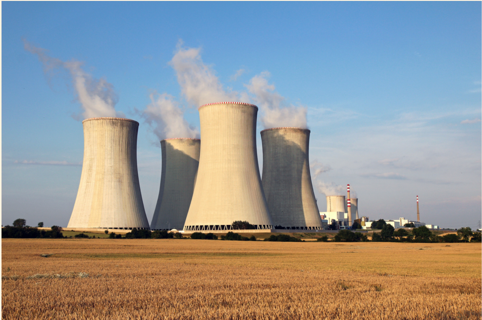
Torre de refrigeración en forma de hiperboloide de una hoja Imagen por cortesía de carrierrentals.com
