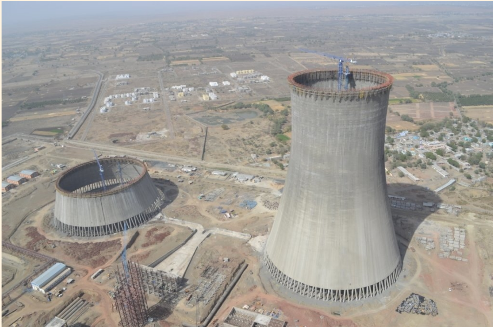
Construcción de las torres de refrigeración de la central térmica de Kalisindh (India) BGR Energy Systems Ltd. Imagen por cortesía de comansa.com
