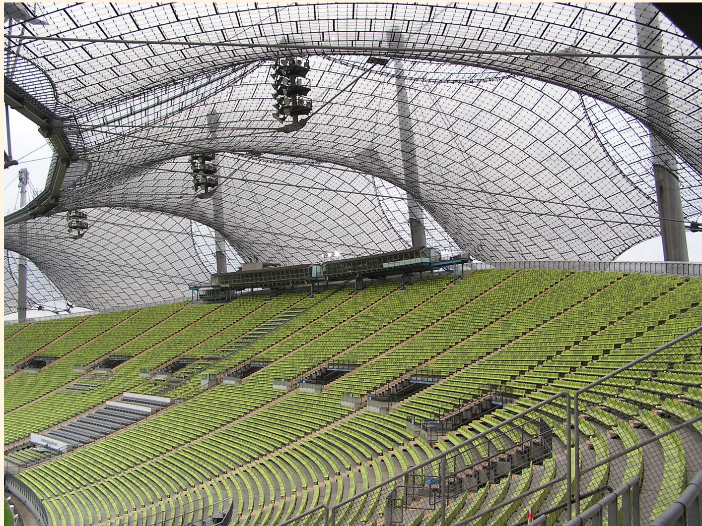
Cubierta del Estadio Olímpico (Munich) Frei Otto. Imagen por cortesía de recorrermundo.com
