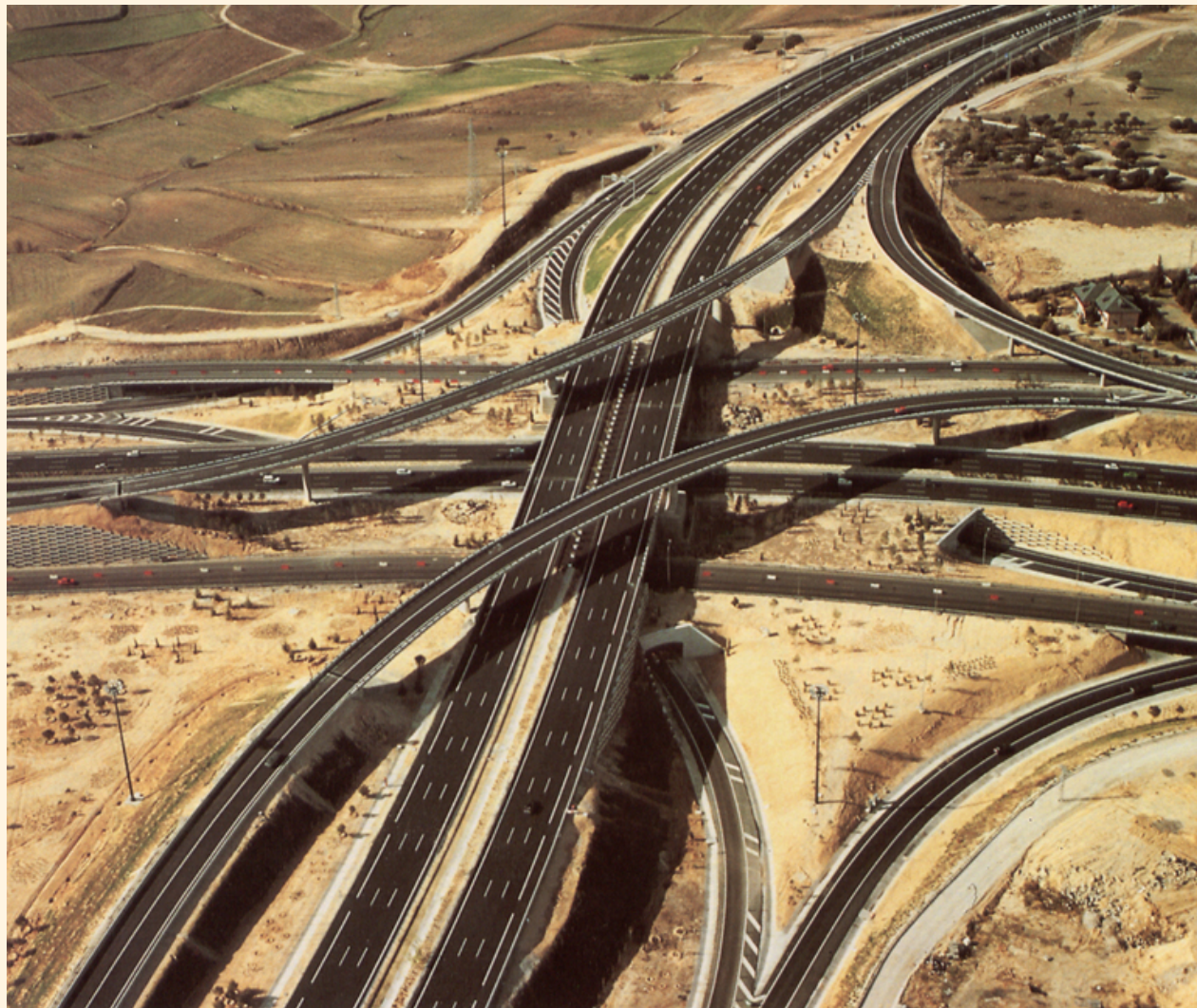
Nudo de enlace del distribuidor M-40 con la carretera de Madrid-Burgos J.J. Arenas y M.J. Pantaleón. Imagen por cortesía de Apia XXI
