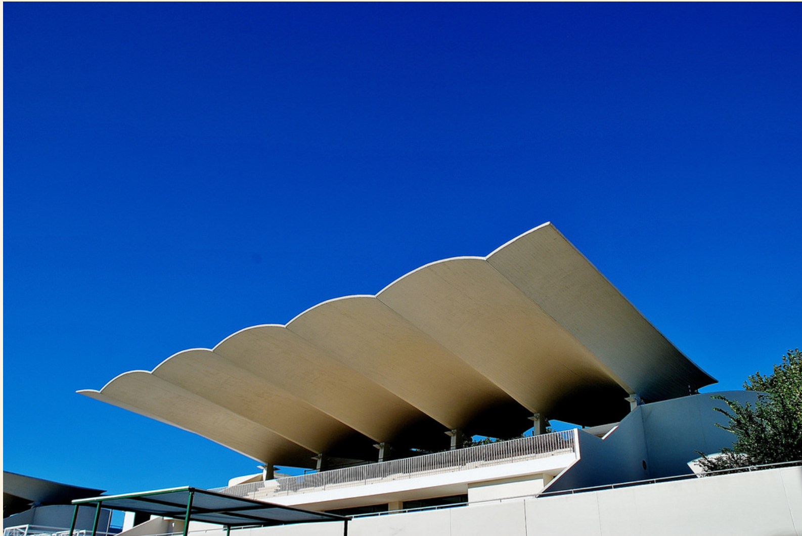
Cubierta del Hipódromo de la Zarzuela
