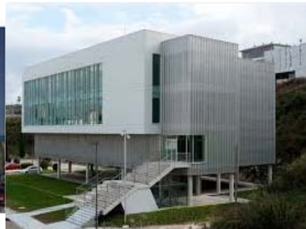
Building: Área Científica: Class 2.3
